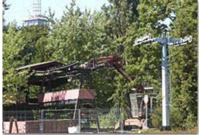
Relikt kurz vor dem Abbruch: von der südlichen Station der Sesselbahn, die 1957 für die Bundesgartenschau gebaut wurde, ist bald nichts mehr zu sehen.
